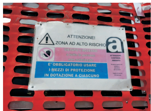
Figura 6.18 - Segnaletica e recinzione di un cantiere di messa in sicurezza (Emarèse)
