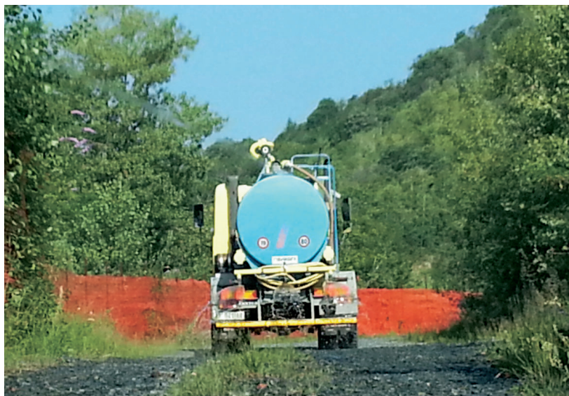
Figura 6.14 - Bagnatura delle piste di accesso
