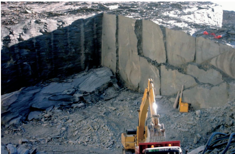
Figura 6.3 - Bancata di serpentino massiccio
