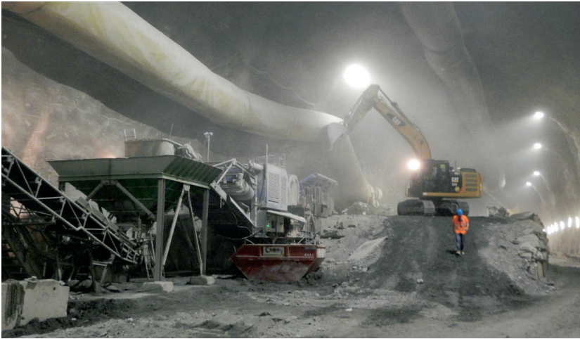
Figura 6.19 - Operazioni di scavo tradizionale in assenza di amianto e gestione dello smarino
