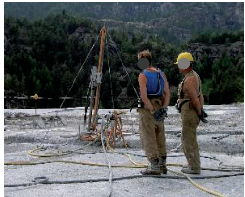
Figura 6.1 - Perforazione della bancata
