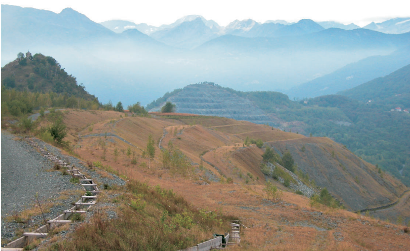
Figura 6.17 - Sistemazione idrogeologica e regimazione delle acque meteoriche dell'area di cava di Balangero-Corio
