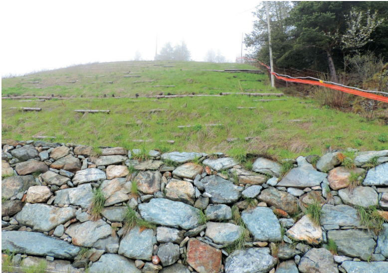
Figura 6.13 - Interventi stabilizzanti del versante
