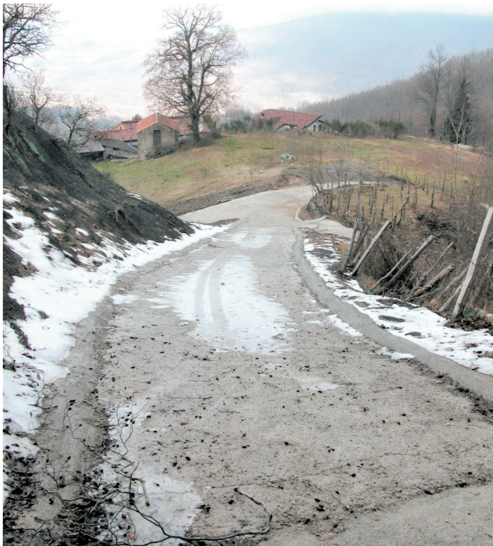
Figura 6.23 - Interventi di copertura del versante con affioramento di amianto naturale
