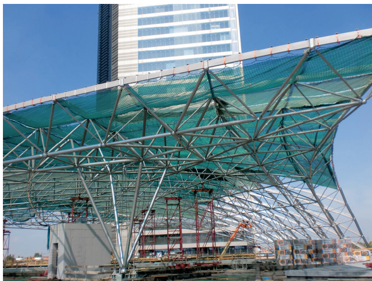
Figura 5.3.2-2 - Esempio di sistema S: copertura in acciaio
