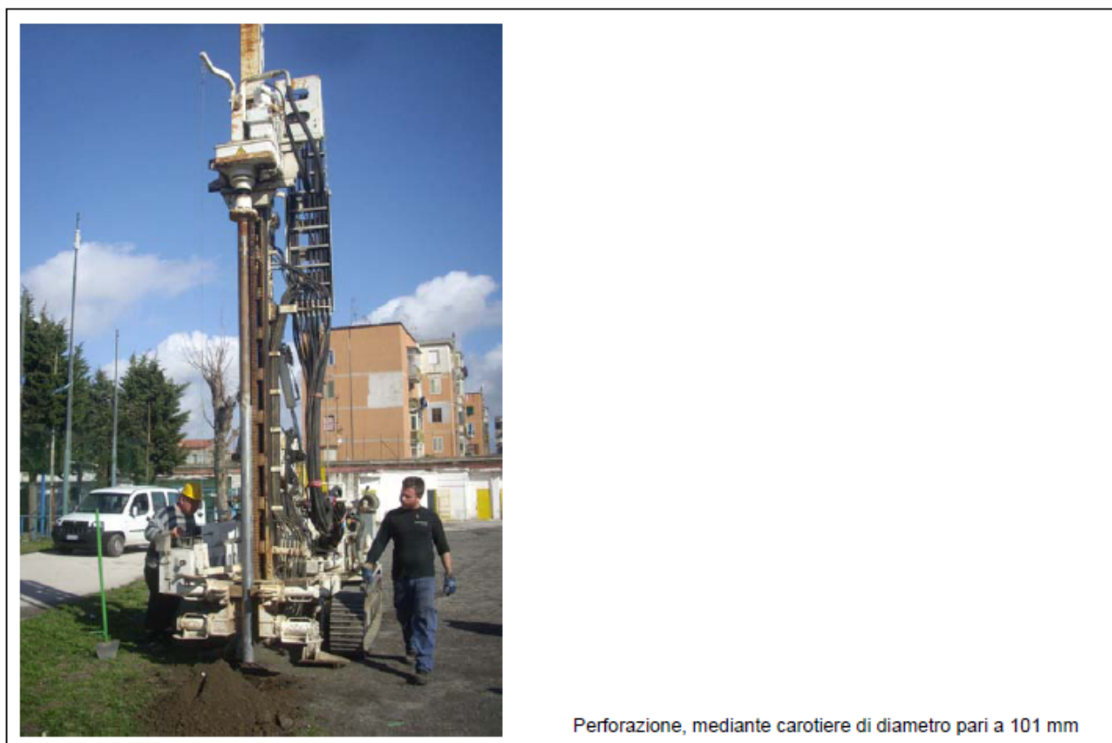
Figura 52. Perforazione mediante carotiere di diametro pari a 101 mm
